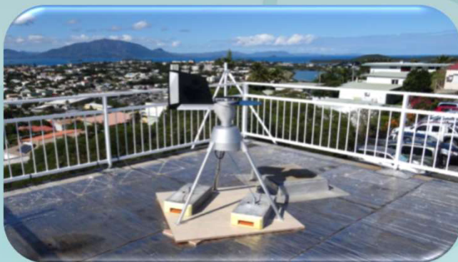
Photographie du capteur : toit du bâtiment Météo France Nouvelle-Calédonie
